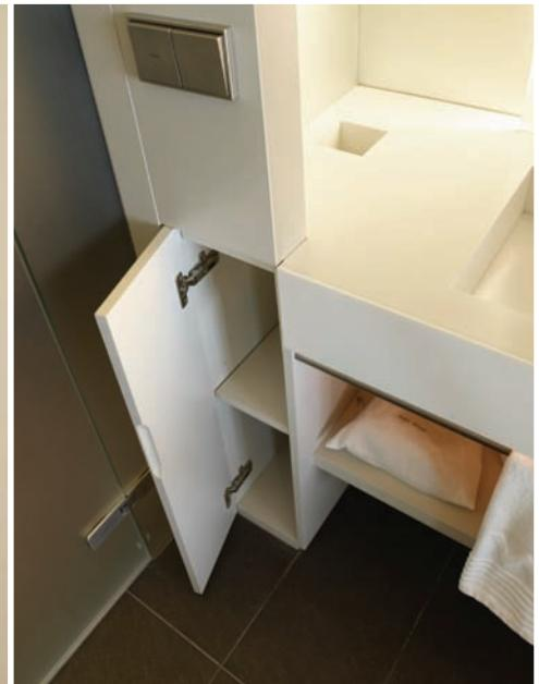
Puertas enrasadas modelo FLAT, acabado lacado blanco. Tapetas enrasadas con el muro, entrega mediante perfil metálico. Numeración de habitación retroiluminada enastada en la tapeta lateral. Armario modelo FLAT, lacado blanco. Con tirador Vela en aluminio brillo.
