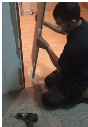
Instalación de marcos verticales y superior
