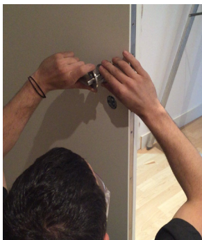
Instalar maneta, cilindro, escudo y mirilla
