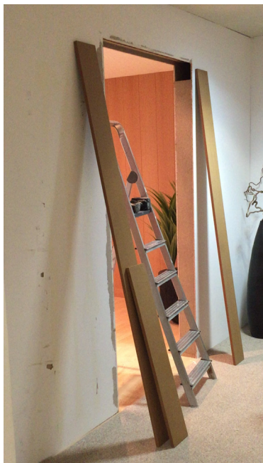
Montaje del premarco
