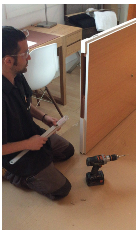
Instalar muelle de cierre oculto antes de colgar la puerta
